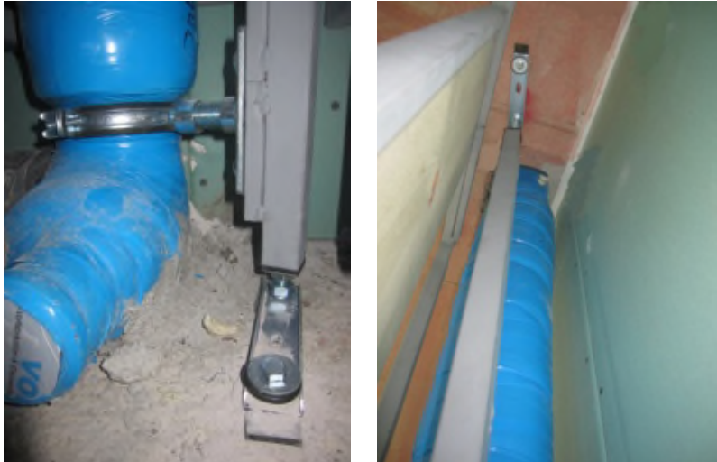
Abbildung 5: Übersicht der Befestigung des Fallstrangs an den freistehenden Metallständern
